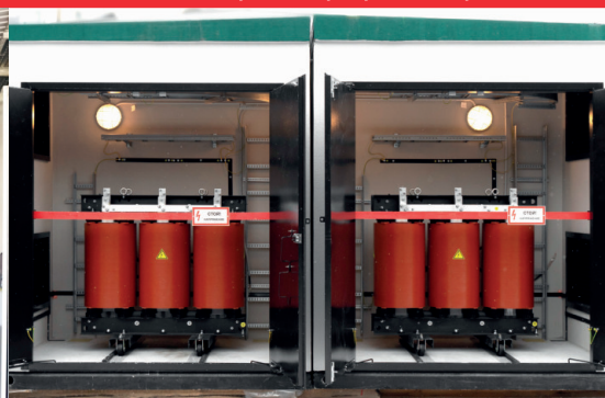
Отсек трансформатора
