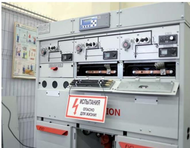
Проведение испытаний моноблока EVOLUTION в электро-технической лаборатории АЙДИ-ИНЖИНИРИНГ
